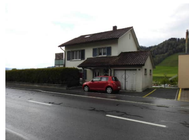
Kantonsstrasse Parz. Nr. 66
