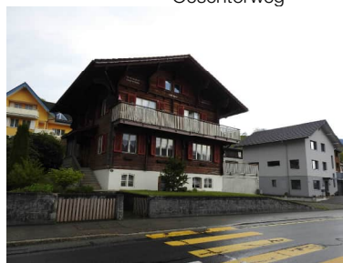
Kantonsstrasse Parz. Nr. 92, 1398
