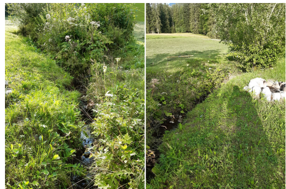
Abb. 5: Fotos Bereich Angstboden
